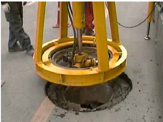
사진-1 하부프레임 부착 컷팅기 Setting시의 아스팔트포장 변형여부
