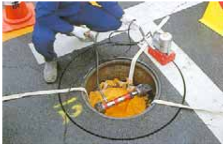
3. 절삭된 노면에 유압실린더 설치
