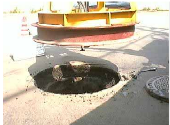
사진-1 하부프레임 부착 컷팅기 Setting시의 아스팔트포장 변형여부
