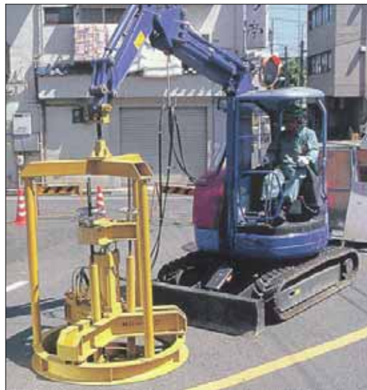
사진 1.12 MR 2 공법의 맨홀보수기계장치
