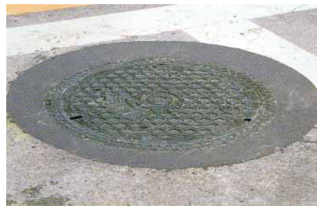
8. 포장마감재를 주입하여 공사를 완료
