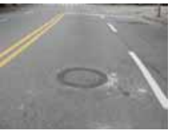
공사 후 사진
